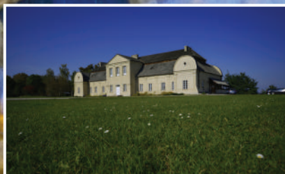
Foto/photo: Pałac Suchodolskich w Dorohusku/ Suchodolski palace in Dorohusk.
